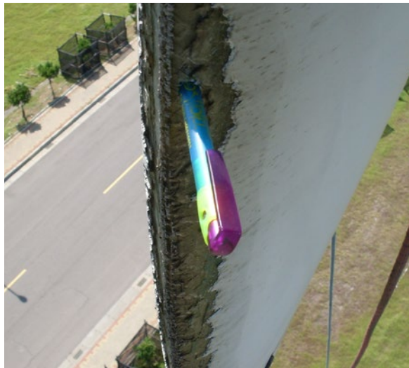
Abb. 1: Starke Beschädigung durch Erosion – Hier ist es fast zu spät, um über Abhilfe nachzudenken
