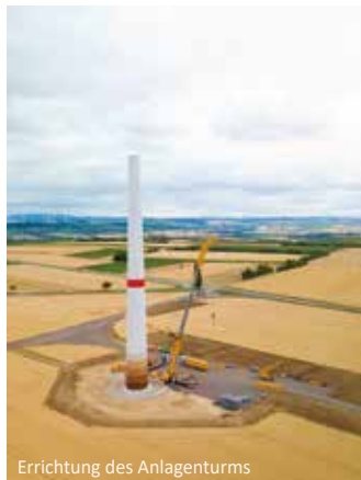
Errichtung des Anlagenturms
