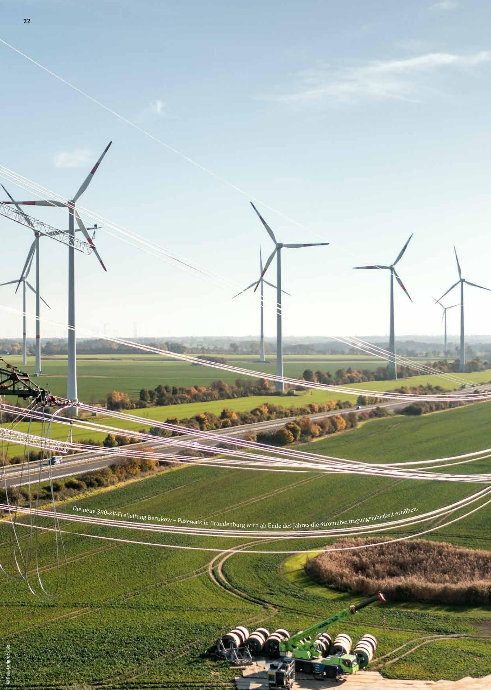
Die neue 380-kV-Freileitung Bertikow – Pasewalk in Brandenburg wird ab Ende des Jahres die Stromübertragungsfähigkeit erhöhen.
