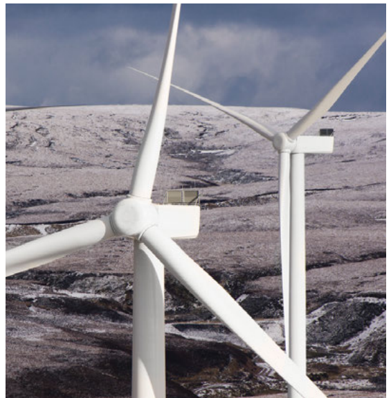
Highlander: Diese Turbinen im nördlichen Schottland stehen idyllisch, aber auf schwierigem Terrain, und warten nach der Errichtung noch auf den Netzanschluss.
