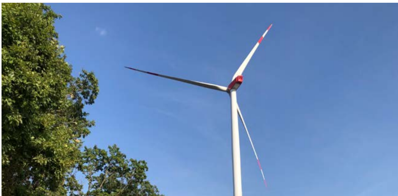
Leuchtturmprojekt Windpark Wargolshausen/Wülfershausen in Bayern
