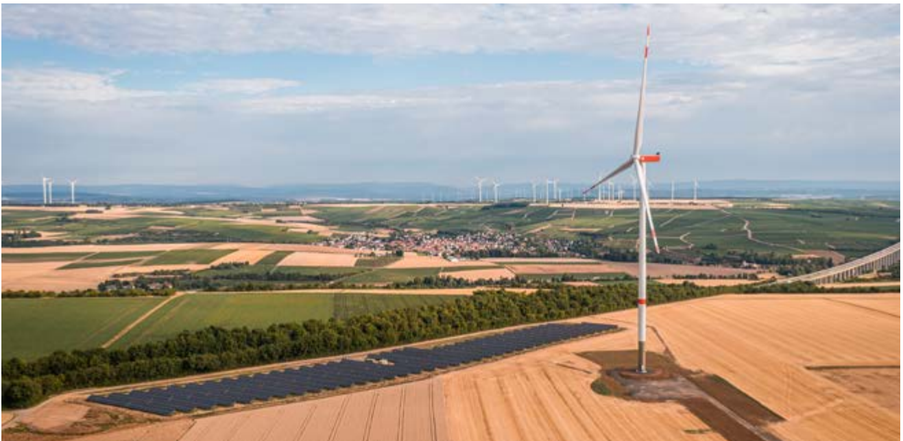
Kombinierte Technik in Wahlheim/Rheinland-Pfalz: Windkraft, Photovoltaik und Hybridbatterien verbinden Stromerzeugung und Speicherung.
