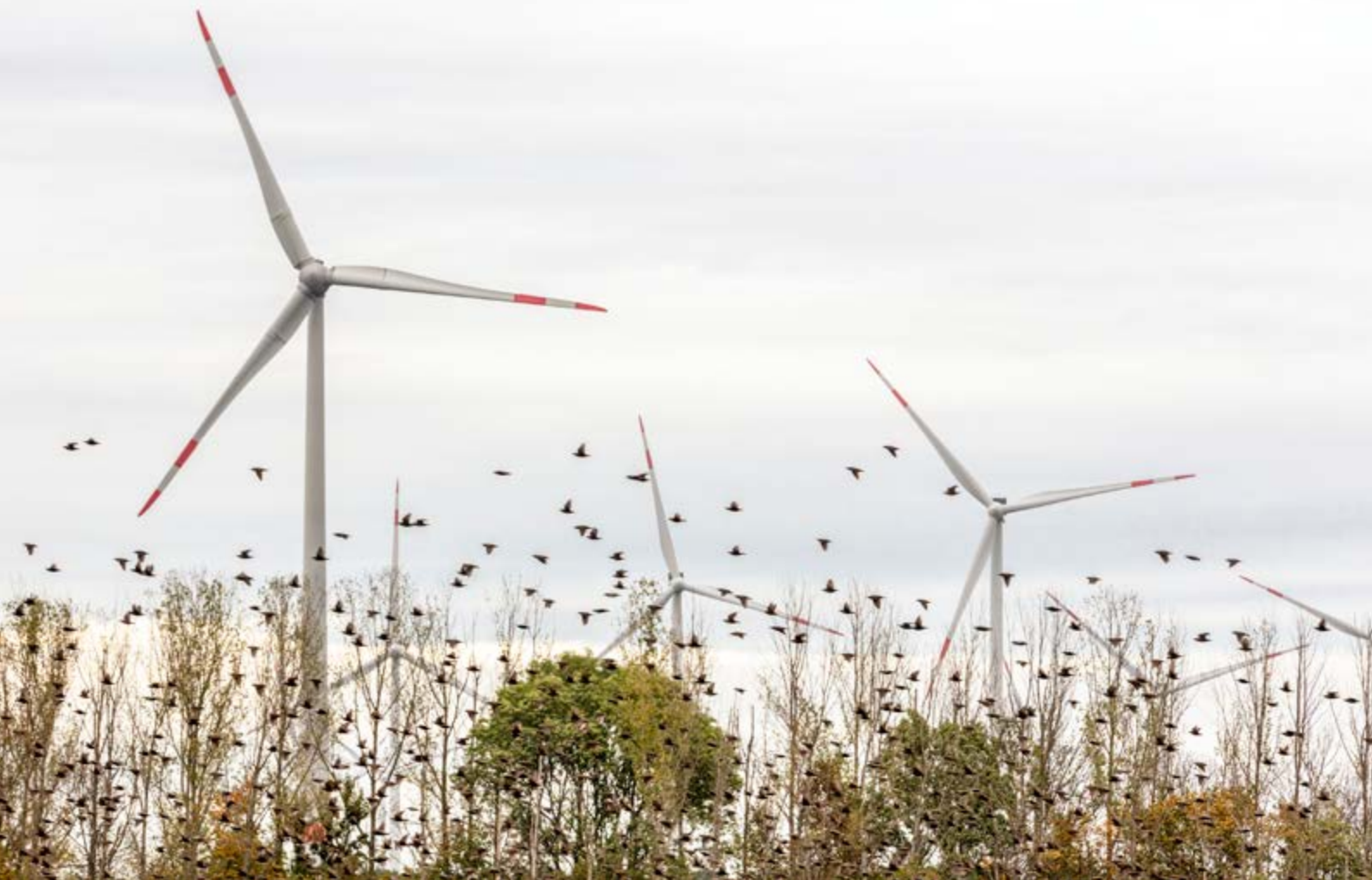
Windpark Tempelfelde Wilmersdorf in Brandenburg
