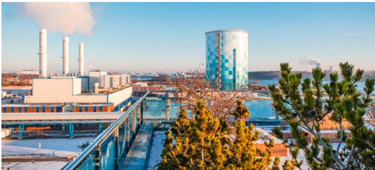
Wärmespeicher der Stadtwerke Rostock mit 55 Metern Höhe und einem Inhalt von 45 Millionen Litern Wasser
