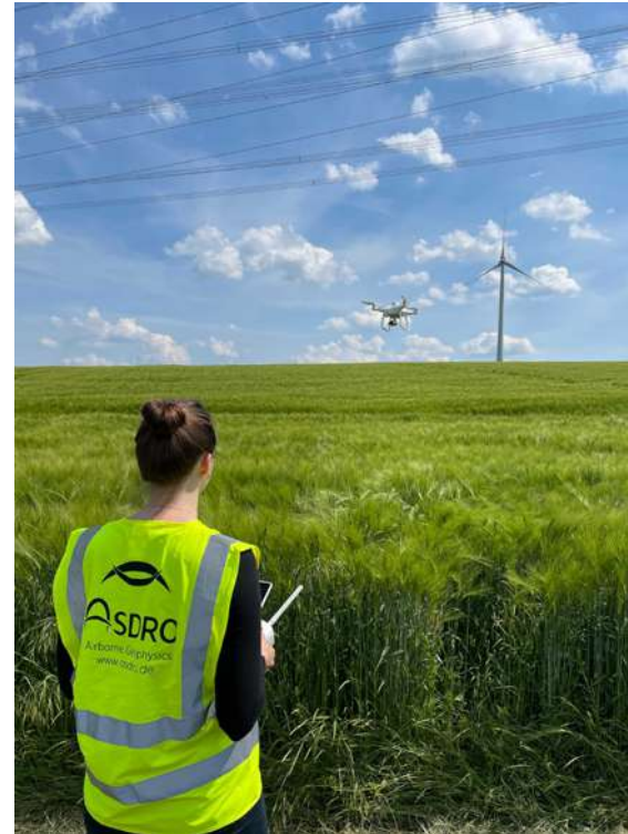
Photogrammetrische Luftbildaufnahmen sorgen für ein digitales 3D-Modell der Baustelle und können als vermessungsrelevante Datengrundlage dienen.
