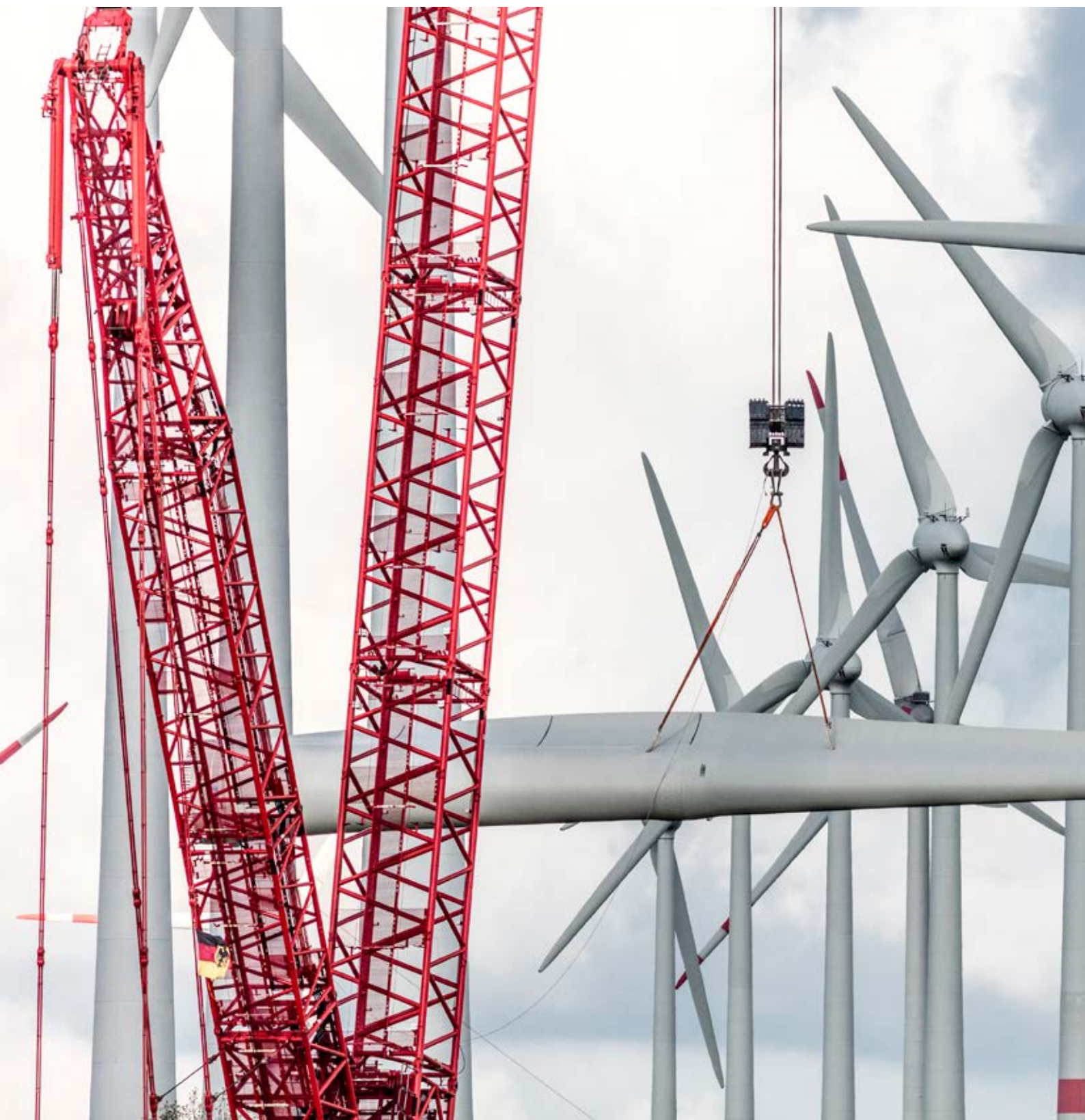
Aufbau Enercon E126 im Windpark Feldheim, Brandenburg. Foto: Paul-Langrock.de
