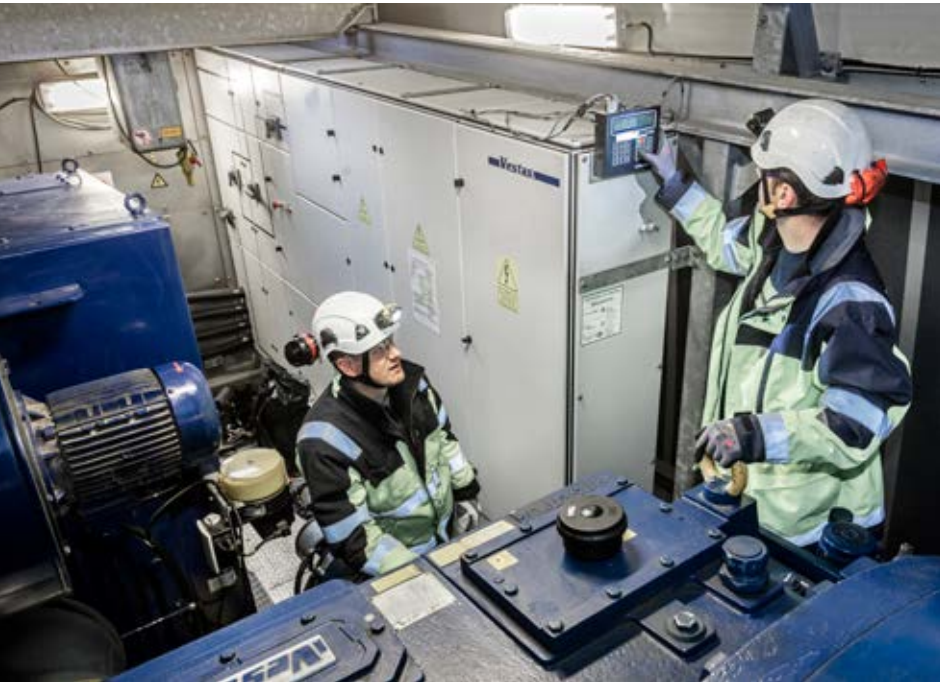
Wartungsarbeiten in einem Windpark bei Cottbus. Foto: Paul-Langrock.de
