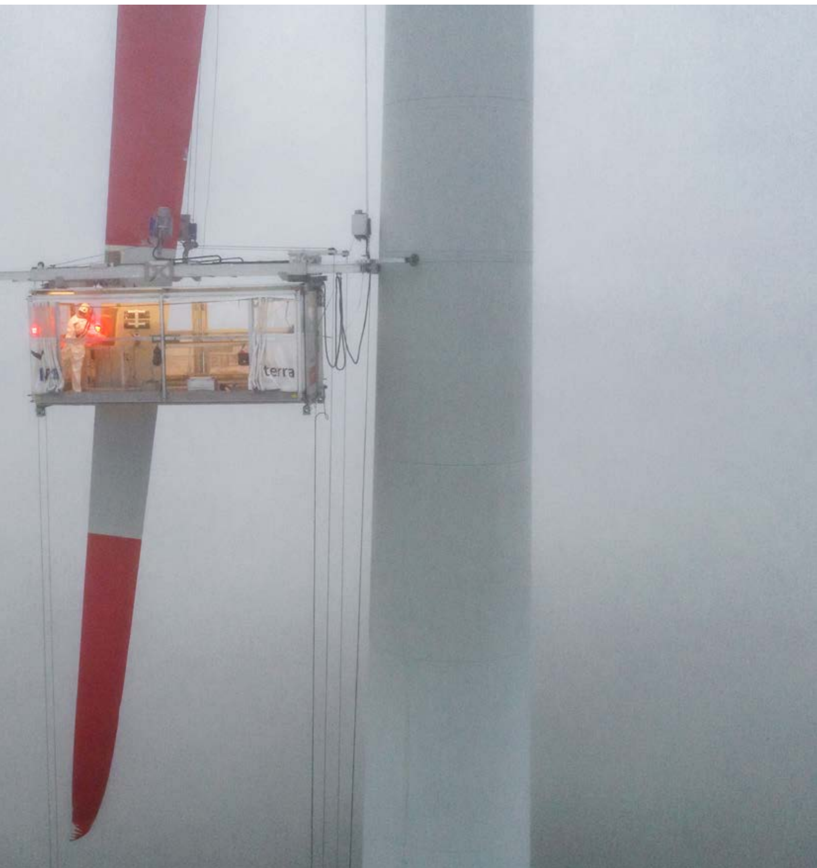
Servicearbeiten im Windpark. Foto: Paul-Langrock.de
