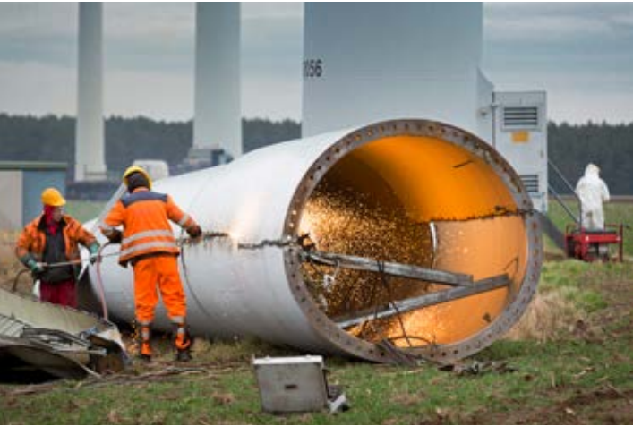
Demontage einer DeWind Windenergieanlage nach einem Turmbruch. Foto: Paul-Langrock.de
