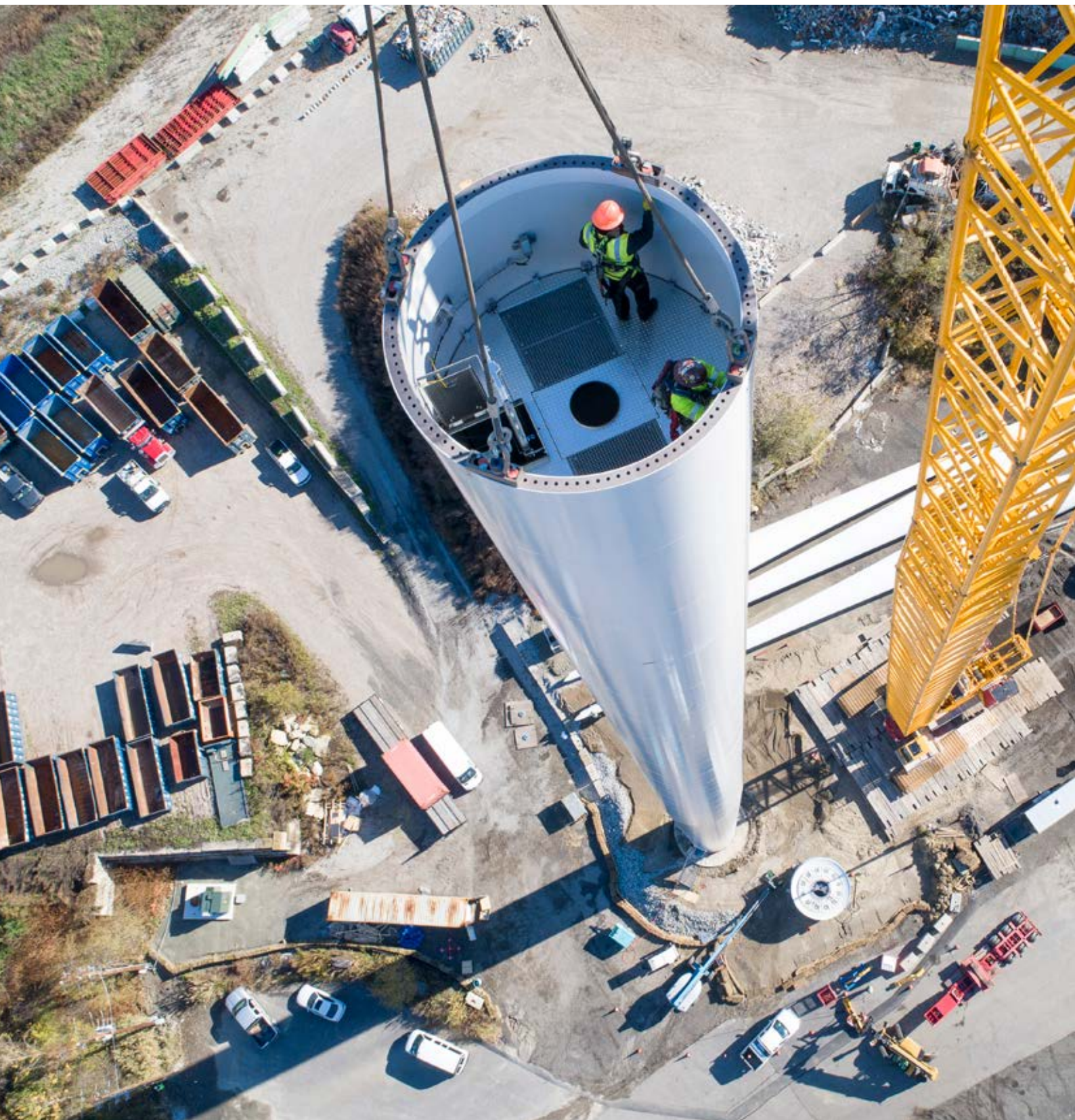
Aufbau des Windparks Johnston in Rhode Island, USA. Foto: Ulrich Mertens
