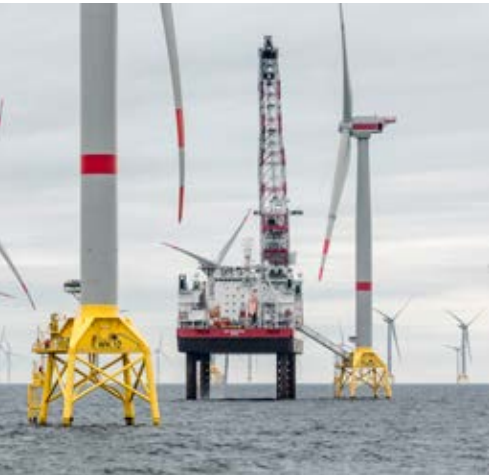
Wartungsarbeiten im Offshore-Windpark Wikinger, Foto: Paul-Langrock.de
