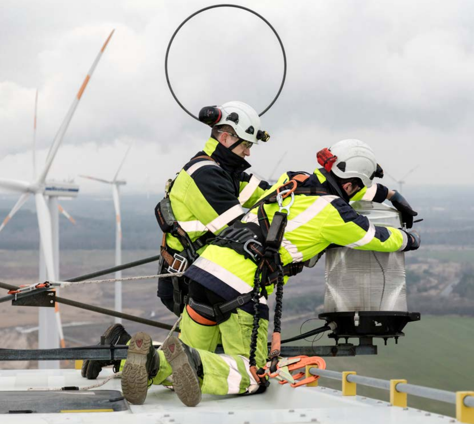
Wartungsarbeiten an einer Windenergieanlage in ehemaligem Braunkohletagebauebiet bei Cottbus. Foto: Paul-Langrock.de
