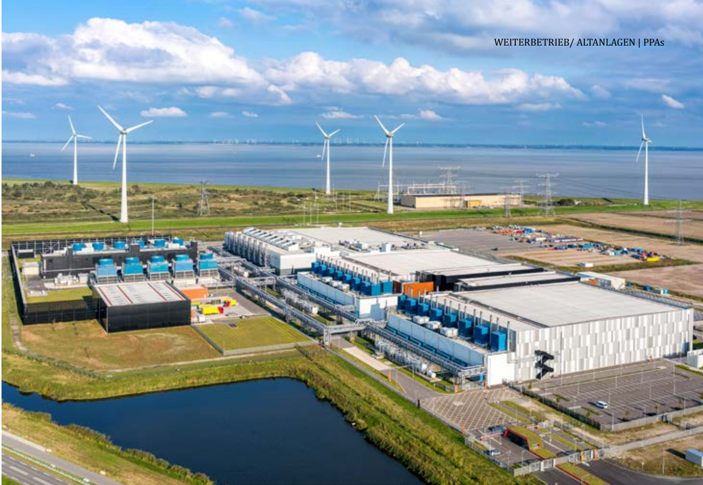
Google-Datacenter in Eemshaven. Foto: Alphabet/Google
