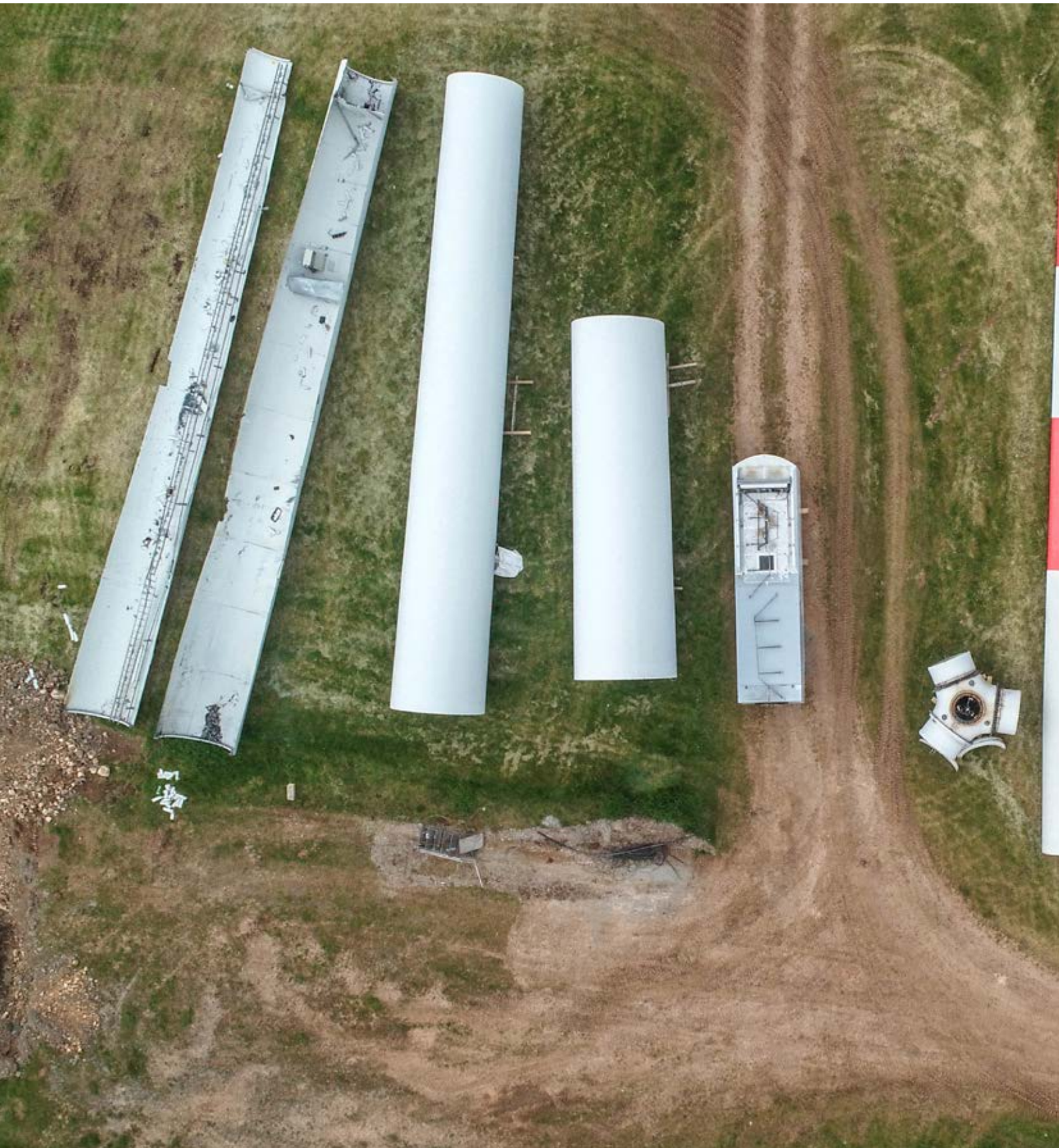
Rückbau von vier Altanlagen in Adorf am Diemelsee. Foto: Hagedorn
