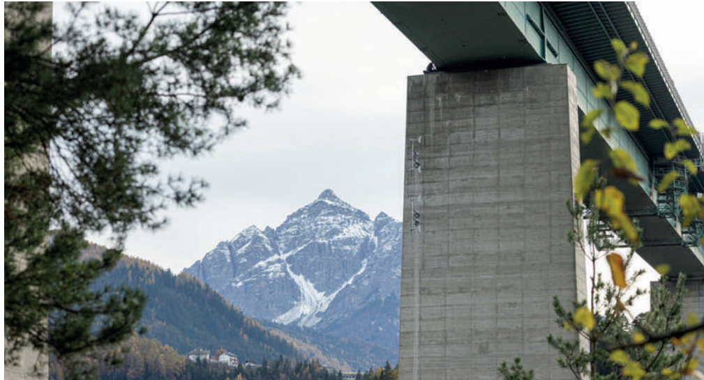
Blick auf die Europabrücke mit installierten MOWEA-Turbinen
