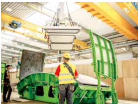
Die Tunnelwände für die neue U-Bahn in Łódź sind schon fertig: Die PKP investiert rund 380 Millionen Euro in das Projekt – das von der EU gefördert wird.
